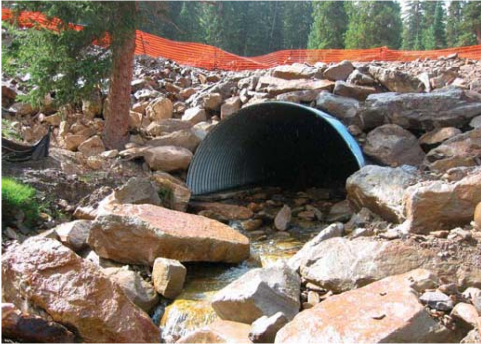
Orebreni limeni luk - propust
